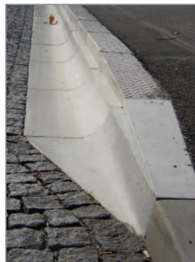
Obrázek 4: Detail kasselského obrubníku, který umožňuje příjezd vozidla MHD blíže k nástupišti
