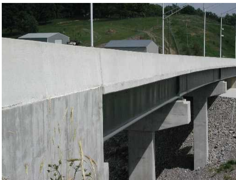
Obr. 1 – Boční pohled na most s přímo pojížděnou mostovkou, která je podporována spojitým ocelovým nosníkem tvaru I
