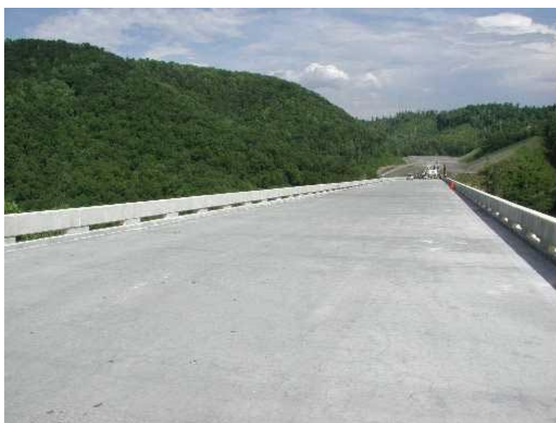
Obr. 5 – Tenká, bezespárá, cementobetonová vozovka na mostě
