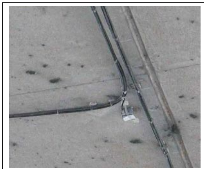
Obr. 3: Umístění snímače na pohledu mostu
