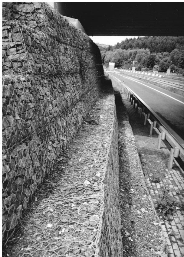
Obr. 2 Gabion jako součást mostní konstrukce
