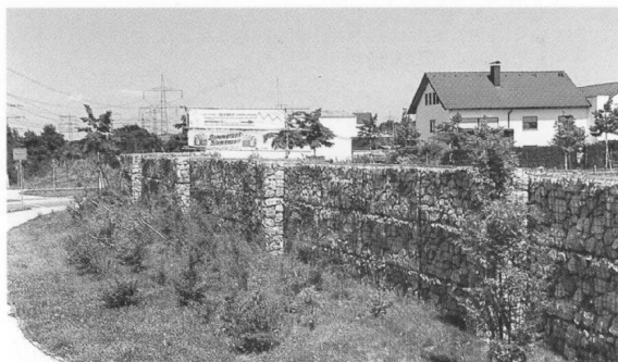
Obr. 4 Gabion v intravilánu
