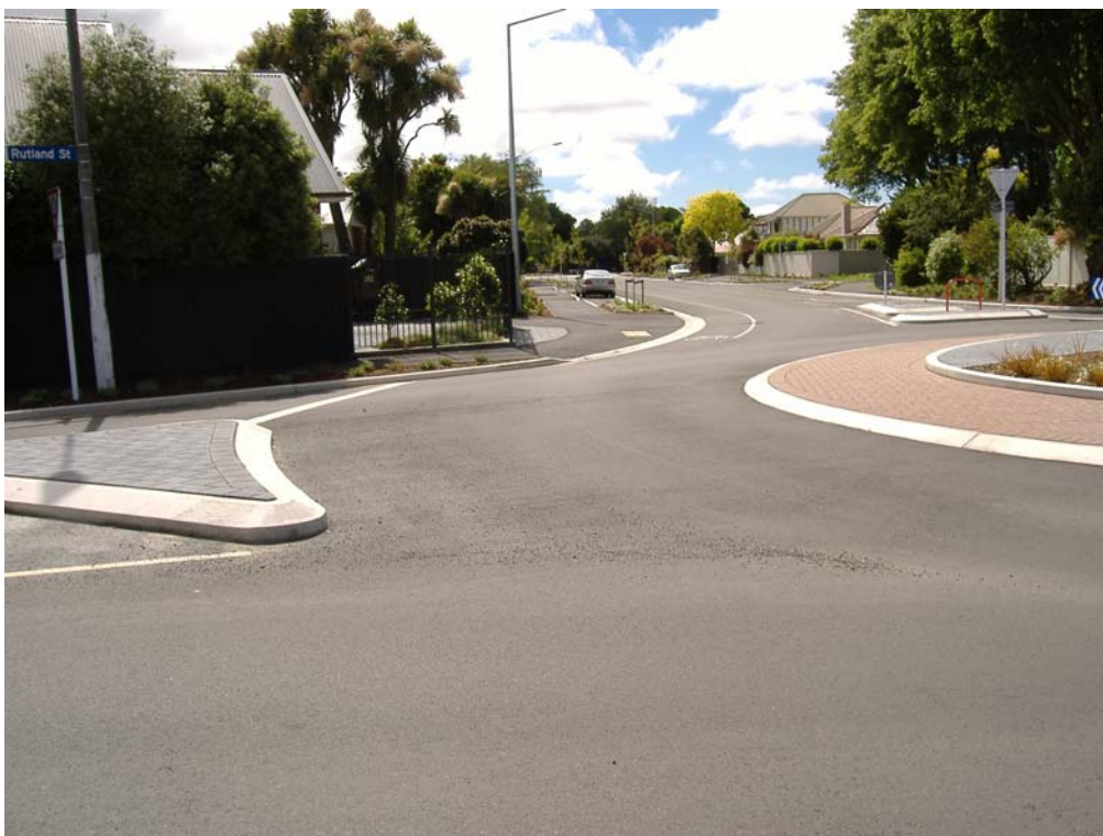
Obr. 5 – Předimenzovaná šířka jízdního pruhu, vhodné barevné odlišení středového prstence, netangenciální napojení vjezdu – křižovatka na Trafalgar Street, Christchurch (foto autor)
