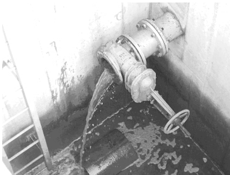
Obrázek 4 Přítok vody z dálnice do DUN
