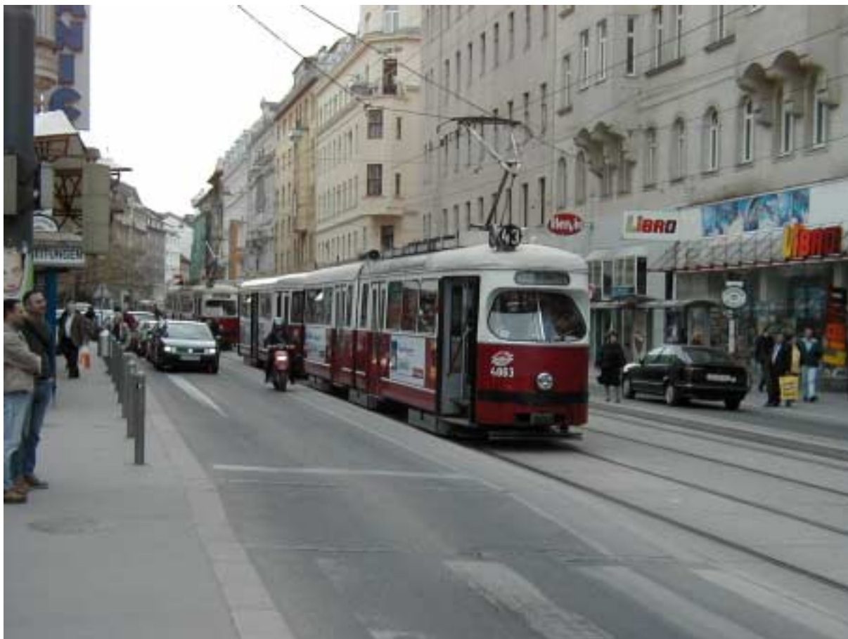
Obrázek 2: Skodagasse ve Vídni – tramvajová zastávka se zvýšenou vozovkou na lince č.43 (foto: Kuratorium für Schutz und Sicherheit, Vídeň, 2003).
