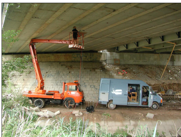
Obr. 3: Lepení snímačů
