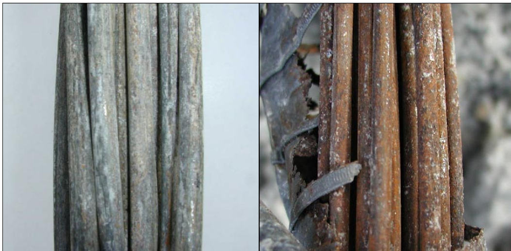
Obr. 5: Stupně koroze k1 a k4
