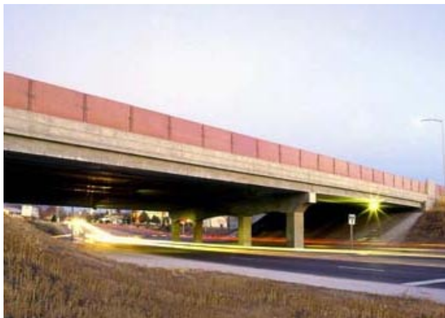
Obr. č. 4: Přemostění Yale Avenue, Denver (Colorado)
