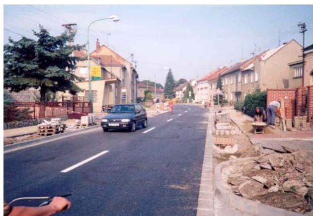
Obr. 4: Probíhající rekonstrukce průtahu (Těšetice, ČR)
