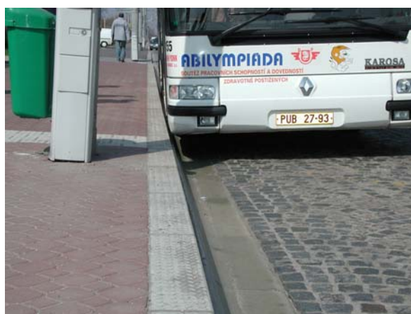
Obr. 15: Profilový obrubník pro těsný nájezd vozidla (Pardubice, ČR)
