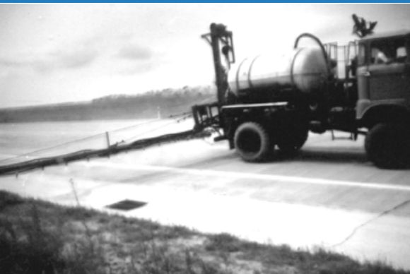
Strojní aplikace na dálnici D47 z roku 1992
