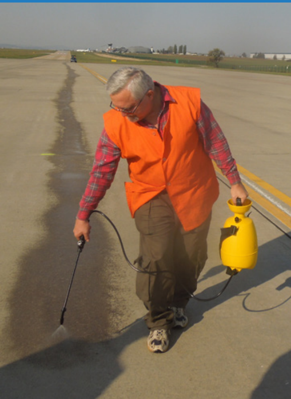
Ruční aplikace Emulze LO na úseku vozovky s cementobetonovým krytem
