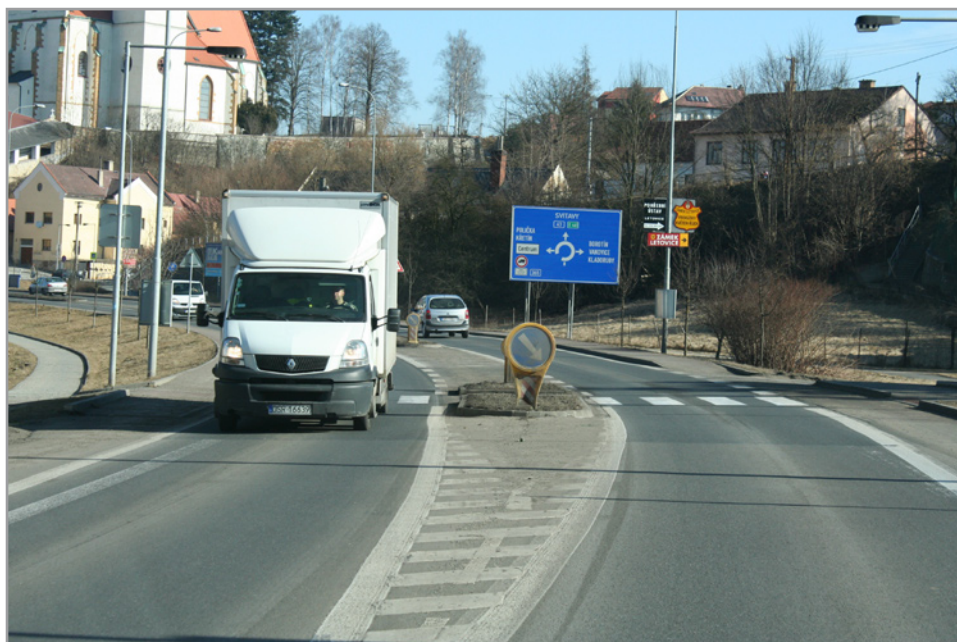
Obrázek 6: Provedení přechodu na větvi silnice I/43 - přecházení na dvakrát a fyzická ochrana chodců vede ke zvýšení bezpečnosti chodců, současně je přechod pro chodce dostatečně viditelný a řidič vozidla včas chodce zaregistruje a lépe respektuje jeho „přednost“ na přechodu.
