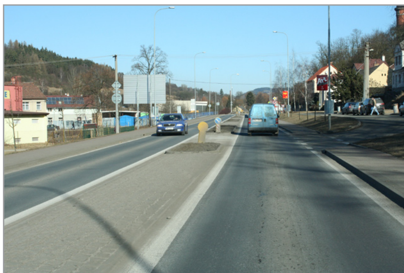
Obrázek 5: Přerušení dělicího pásu v místě potřeby odbočení
