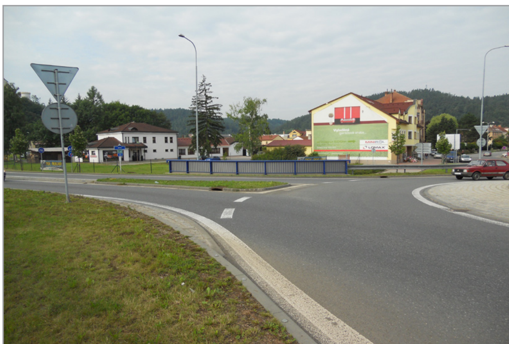
Obrázek 3: Zde je patrný šířkový profil jízdního pruhu na okružní křižovatce v místě napojení větve I/43 ve směru od Brna. Za povšimnutí stojí odvodnění vozovky pomocí podobrubníkových vpustí
