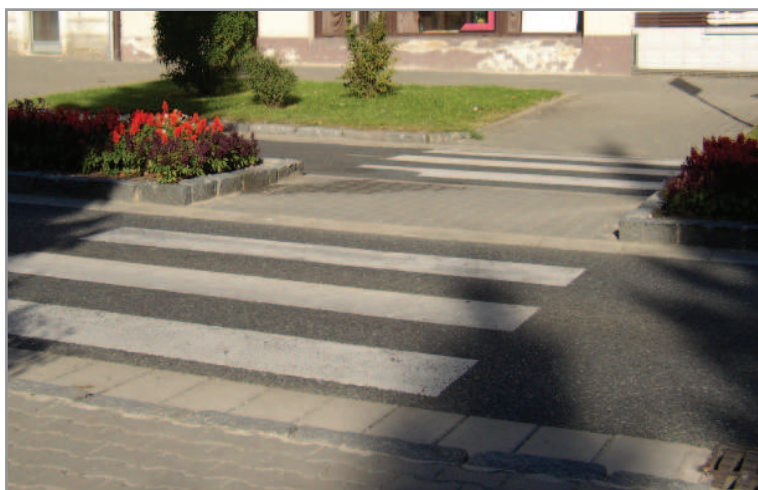
Obrázek 3: Detail snížení obrub, provedení dopravního značení přechodu a ozelenění čel ostrůvku
