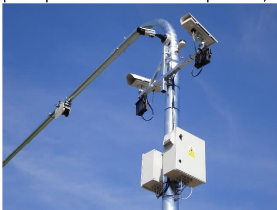
obr. kamery systému vysokorychlostního vážení zdroj: Centrum dopravního výzkumu, v. v. i
