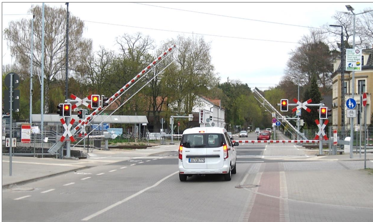
obrázek: Příklad moderního řešení přejezdu se sekvenčním sklápěním závor a kontrolou volnosti přejezdové plochy pomocí radaru (Borgsdorf u Berlína, SRN), zdroj: Centrum dopravního výzkumu
