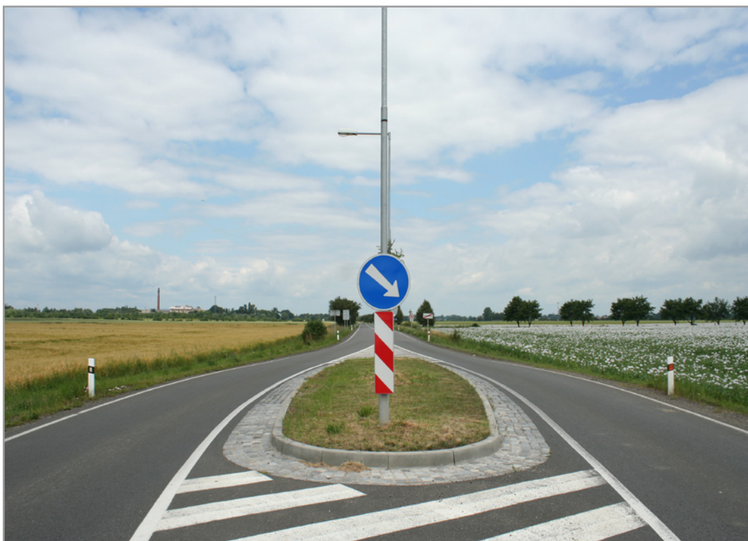
Obrázek 5: Detail obrubníku s tzv. „rybím okem“ a šířkového uspořádání dlážděného okraje ostrůvku
