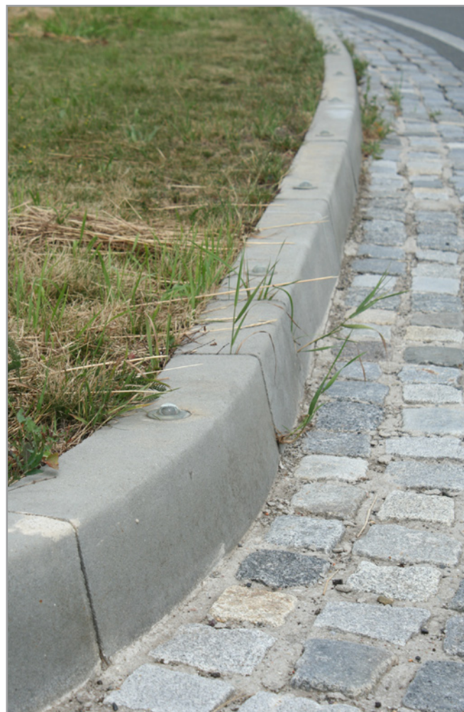
Obrázek 5: Detail obrubníku s tzv. „rybím okem“ a šířkového uspořádání dlážděného okraje ostrůvku
