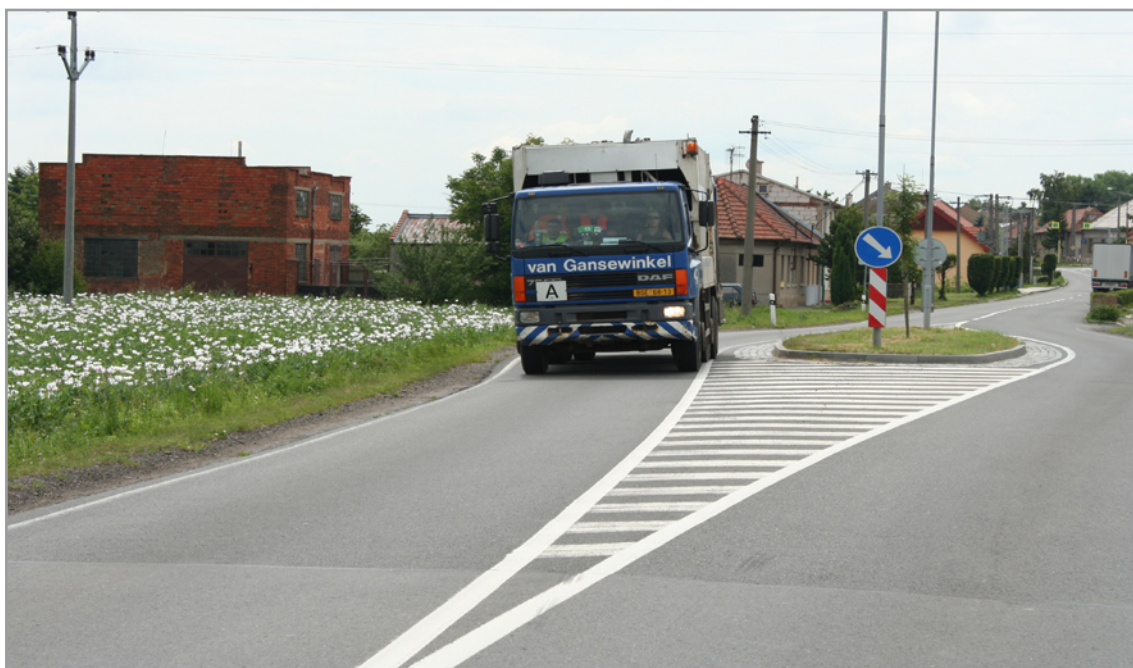
Obrázek 8: Šířku jízdního pruhu v místě ostrůvku dokladuje průjezd nákladního vozidla. Vzhledem k relativně malé šířce jízdního pruhu dochází zejména při vyšších rychlostech ke sjetí vozidla na nezpevněnou krajnici
